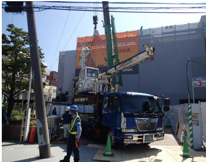
狹隘箇所への楊重搬入
