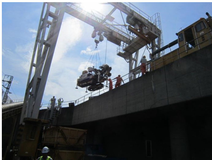
工場内、門型クレーンでの楊重搬入
