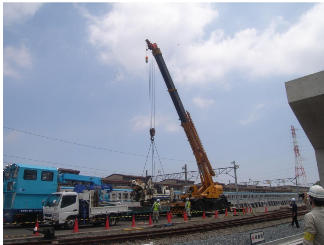
鉄道貨物車両への積替え楊重作業
