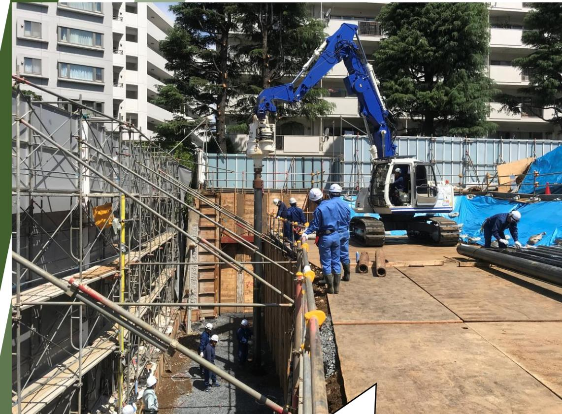
擁壁下の杭埋設のため段差があるところでの施工です。
